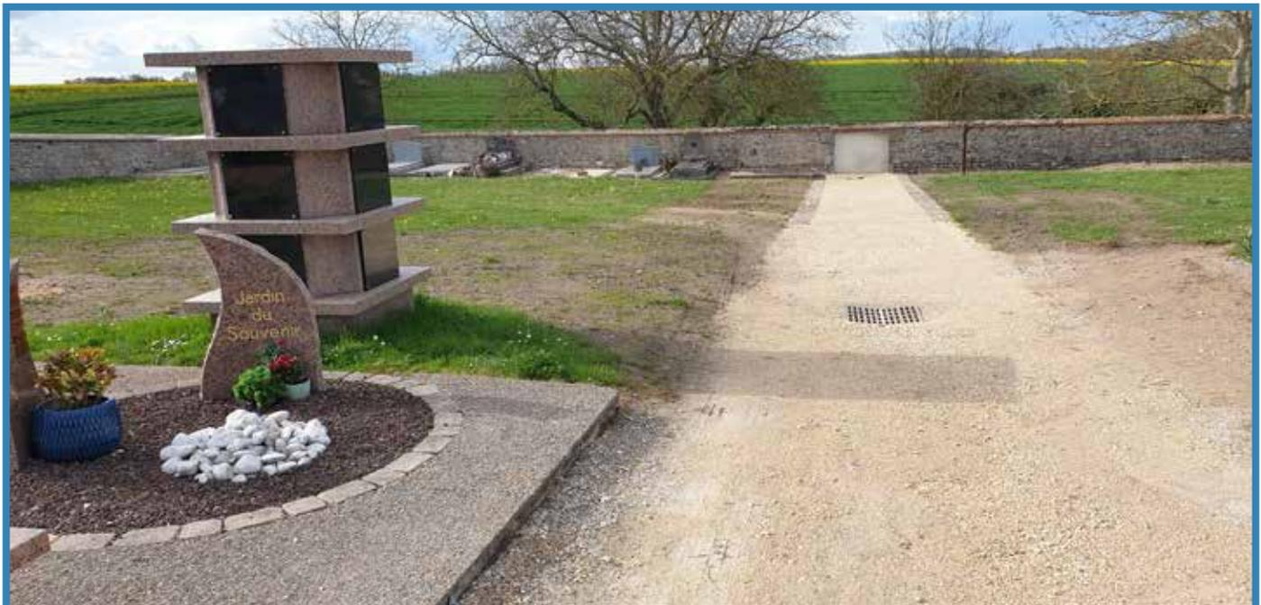
Des travaux d'aménagement ont été réalisés courant février afin de remettre à niveau l'allée centrale du cimetière. En effet, cette dernière était encaissée et conduisait à un portail non utilisé depuis de nombreuses années. Le portail a été supprimé, le mur bouché, l'allée rehaussée et un réseau d'eaux pluviales a
